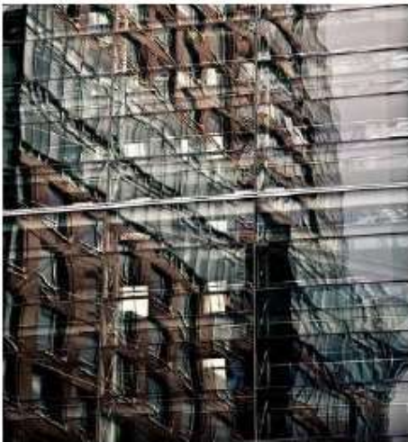
(Exceso de Ondulación)
